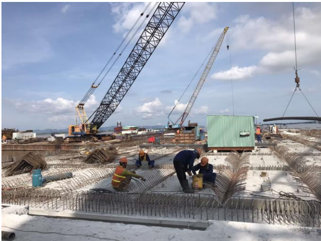
Thi công bến bãi của Cảng NDV giai đoạn 2
