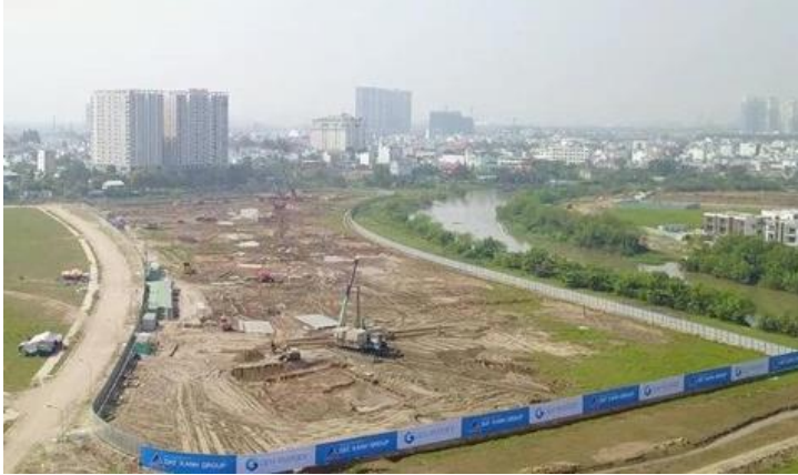
Hình 13: Dự án DXH Riverside – Dự án hiện đang ngưng xây dựng. Dự án đã hoàn tất các thủ tục pháp lý vào đầu Q4/23 và dự kiến sẽ nhận được giấy phép xây dựng cùng với đóng tiền sử dụng đất bổ sung vào Q4/23, dự kiến sẽ tái khởi động vào nửa cuối 2024.
