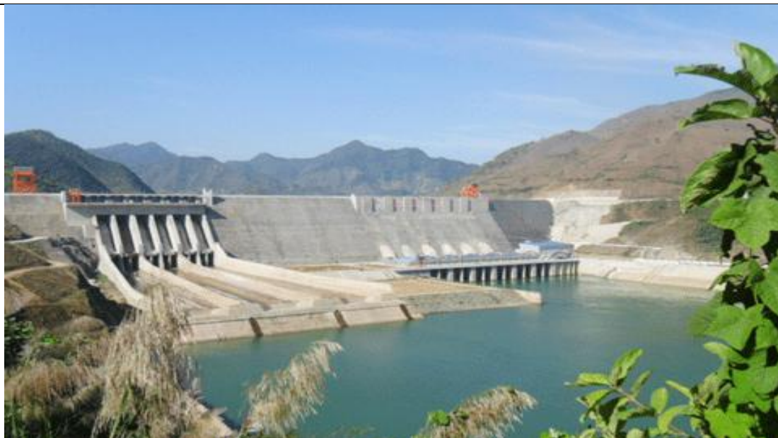
Hình 20: Một số hình ảnh đập, hầm và nhà máy điện
