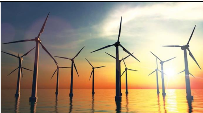
Hình 21: Dự án điện gió Trà Vinh
