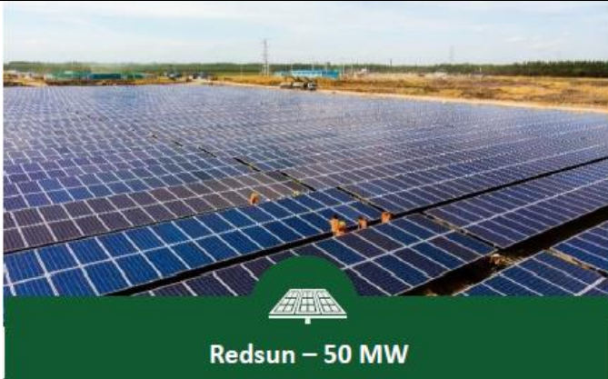
Hình 19: Dự án điện mặt trời Redsun
