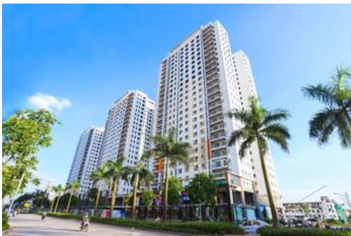
Hình 15: Dự án K-Park (Hà Đông - Hà Nội, bàn giao năm 2018)
