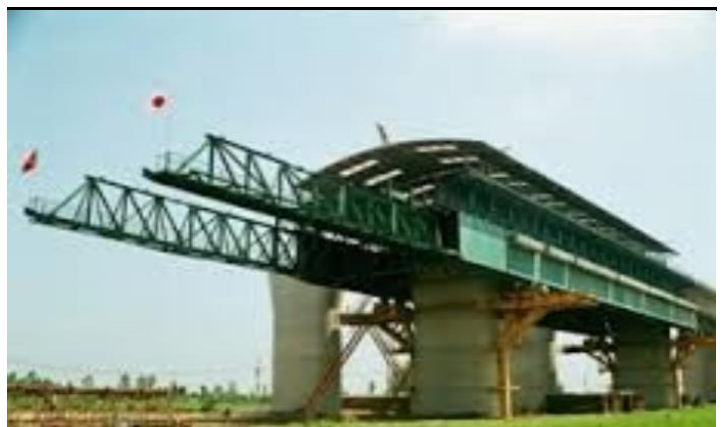
Hình 8: Công nghệ đà giáo đẩy (MSS)
