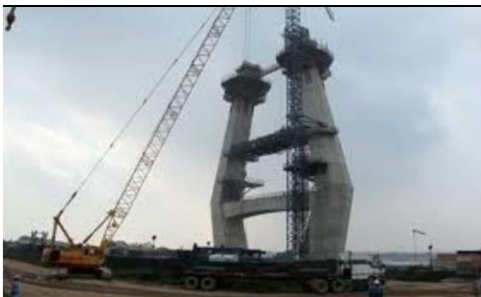
Hình 7: Công nghệ thi công cầu dây văng
