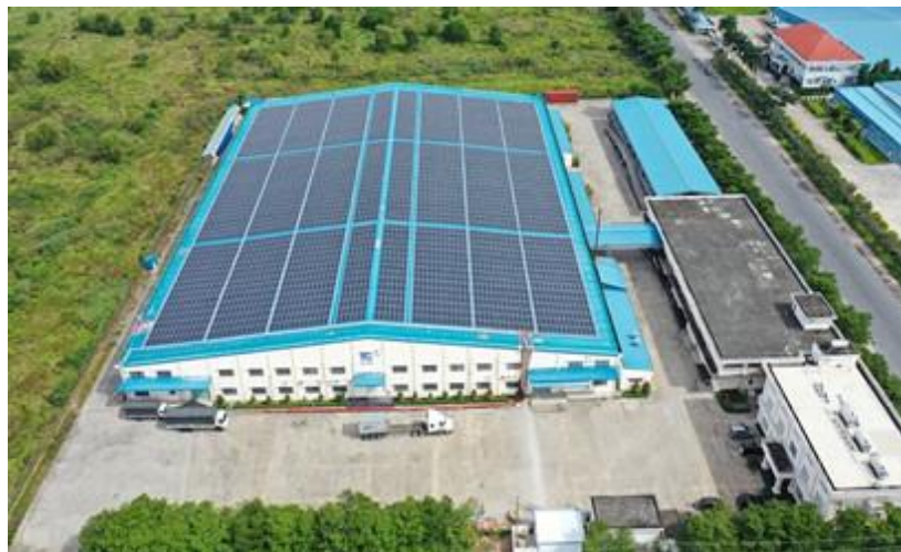
Hình 11: Hệ thống điện mặt trời tại nhà máy
