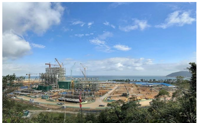
Hình 7: Công trình nhiệt điện Vũng Áng II
