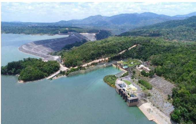
Hình 6: Công trình thủy điện laly mở rộng
