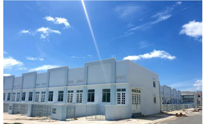
Hình 19: Dự án KDC Thuận lợi
