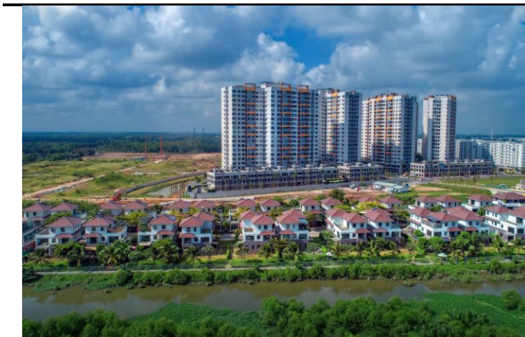
Hình 15: Dự án Mizuki: Phân khu MP9-10 đã cất nóc và phân khu Flora Panoramic đang thi công, dự kiến bàn giao đúng tiến độ Q3/23
