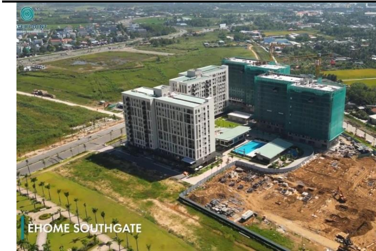
Hình 14: Dự án Southgate (Waterpoint giai đoạn 1): Đã nhận được giấy phép mở bán cho phân khu Pearl; Giai đoạn 1 và 2 của phân khu Ehome đã được bàn giao, Giai đoạn 3 của phân khu Ehome đang được xây dựng (tiến độ đến phần xây móng)
