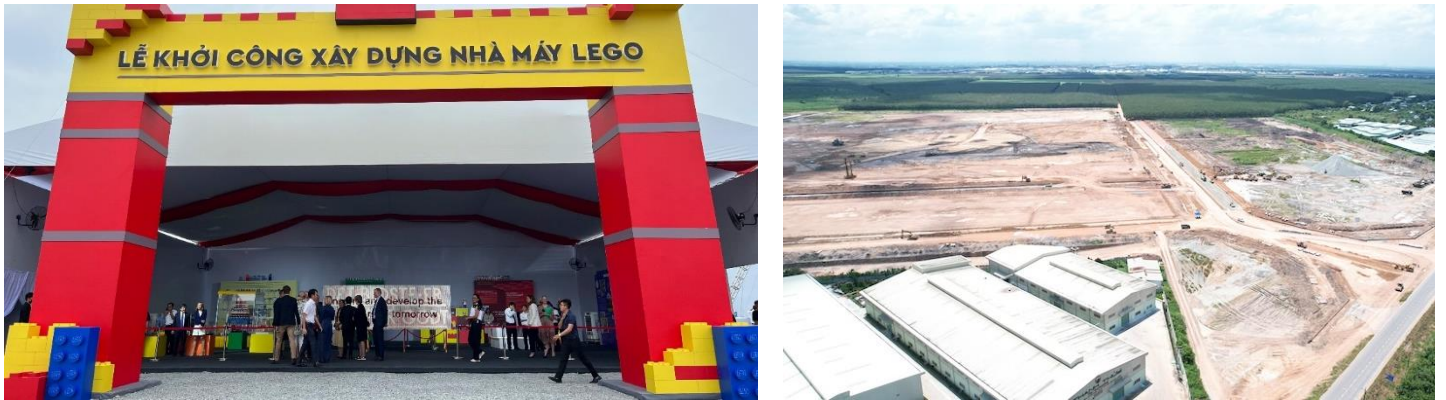
Hình 6: Nhà máy LEGO chính thức được khởi công
