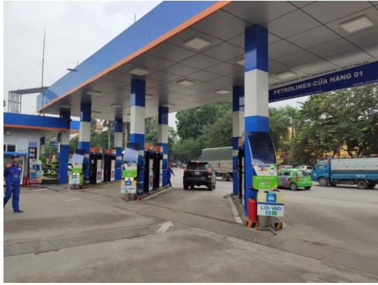
Hình 32: Trạm tự phục vụ của PLX
