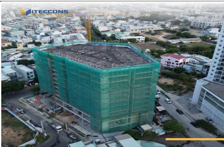
Hình: Dự án Phú tài Central Life cơ bản đi đúng tiến độ
