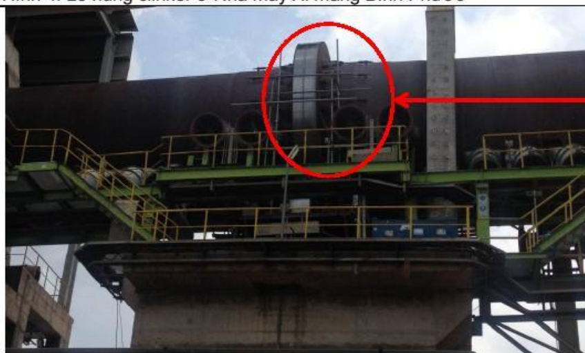
Hình 4: Lò nung clinker ở Nhà máy Xi măng Bình Phước
