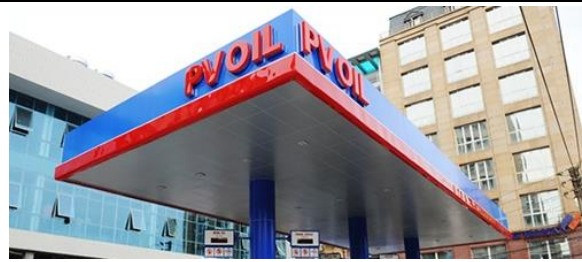
Mái trạm xăng
