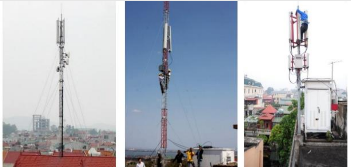
Hình 14: Hình ảnh các trạm viễn thông tại Việt Nam
