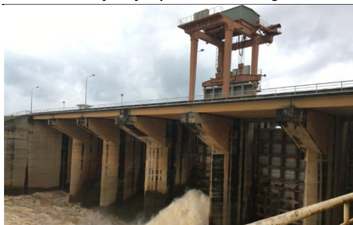
Hình 3: Nhà máy thủy điện Srok Phu Miêng của IDC
